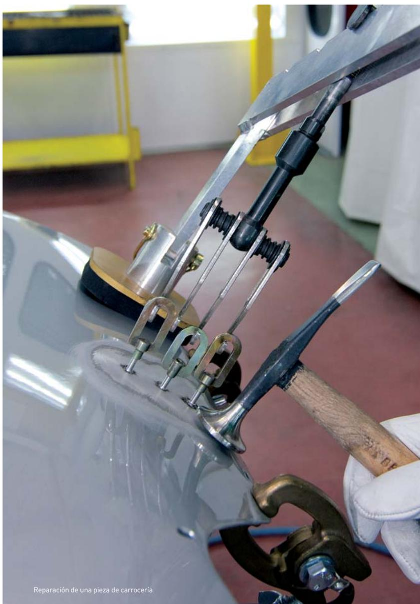
Reparación de una pieza de carrocería
