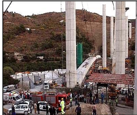
Metal scaffold collapse at Autovía del Mediterráneo worksite in Almuñécar (Granada)
