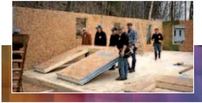
Foto 9. Instalación de paneles estructurales de madera.
